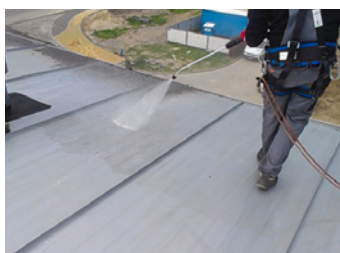
Przygotowanie podłoża za pomocą myjki ciśnieniowej
