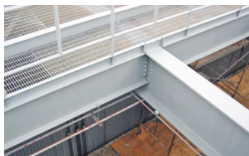
Stalowe konstrukcje mosty, estakady, rurociągi, wieże, wsporniki
